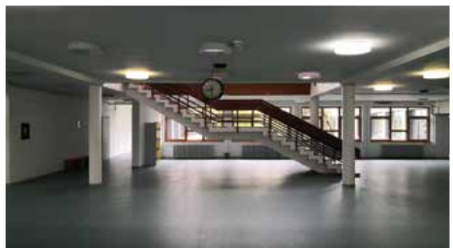
i nakon obnove
