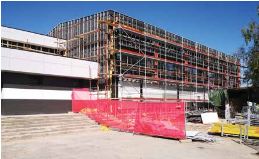
Građevinski radovi snimljeni tijekom postavljanja ventilirane fasade
