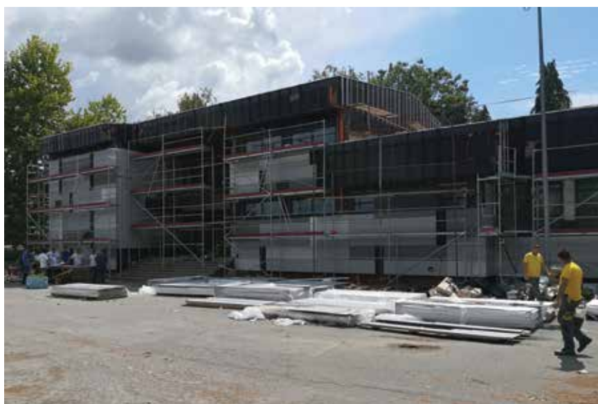
Detalj s gradilišta
